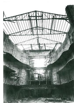
El Teatre Principal en obres el 1949.
