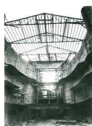
El Teatre Principal en obres el 1949.
